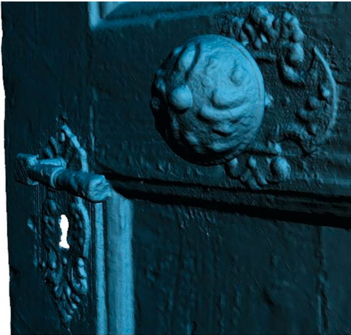
Obr. 68: Příklad výstupu z dokumentace zdobného kování dveří pomocí ručního 3D skeneru. Prostorový pohled na mračno bodů (Vižňov – okres Náchod, kostel sv. Anny, hlavní vstupní dveře; M. Trněný, 2014).
