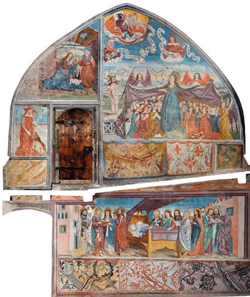
Obr. 6: Fotoplán, věrně zachycující středověké malby, dobře dokumentuje špičkové možnosti současné digitální fotografie. Použit fotoaparát Nikon D800 s rozlišením 36Mpix (36 fotografií). Fotoplán zpracován pro měřítko 1 : 10, rozlišení 0,5 mm, přesnost do 1 cm (Bruck an der Mur – Rakousko, hrad, severní stěna hradní kaple; A. Bruschké, P. Hlavenka, J. Vidman, 2013).
