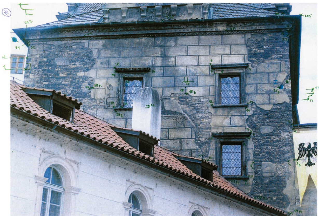
Obr. 49: Díky leonému a dostupnému tisku je dnes zejména pro podrobné měření možné používat místo klasického kresleného náčrtu velké útyisky fotografií. Záznam do nich lze provádět barevnými mikrofixami. Zejména při polárním zaměřování totální stanicí umožňuje tento postup rychlou práci a jednoznačnější identifikaci bodu na náčrtu s reálným bodem na stavbě (Praha 1, Malá Strana, Juditina věž Karlova mostu, východní fasáda; kresba M. Černý, 2011).
